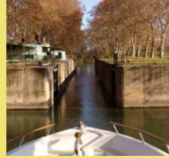
4 Écluse de Prades
